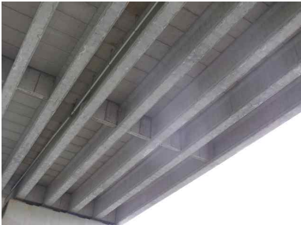
거더 및 바닥판하면 전경
